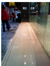
石材護理 (光粉) Stone Protection (Recrystallizing)
